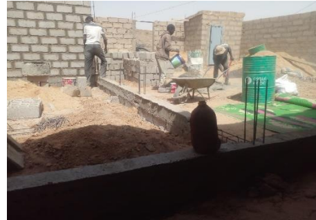
2. Construction de la cuisine
